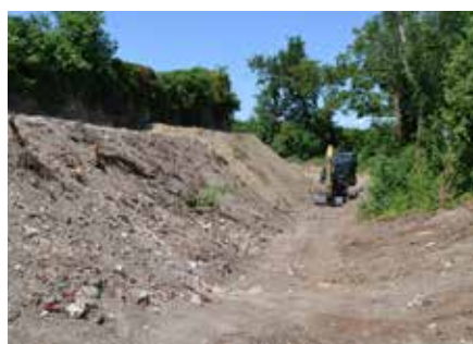
Der Wehrgraben wird saniert.
