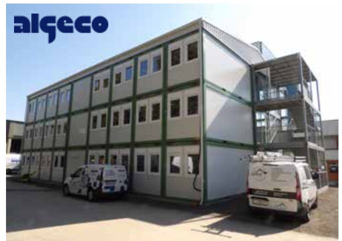
71 Container, aufgeteilt auf drei Geschosse, inklusive zwei Fluchttreppentürmen, wurden an eine Schule in Linz vermietet.
